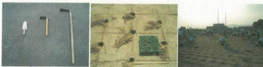
②移植鏝、小鍬(地面が硬ければ唐鍬)で深さ5cm程度の穴を掘る
