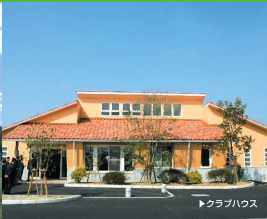
▶宇城市立ふれあいスポーツセンター (熊本県フットボールセンター)
