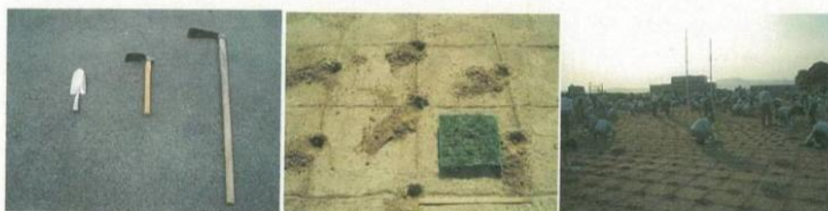
②移植鍬、小鍬(地面が硬ければ唐鍬)で深さ5cm程度の穴を掘る
